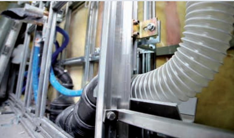
*Gut gerüstet: Hinter Vorwandelementen lassen sich Trinkwasser- und Abwasserrohre verlegen. Mit viel Lärm und Schmutz verbundenes Wand-Aufstemmen entfällt. Solche Tragsysteme aus Metall sind sehr stabil und bieten u. a. Einbau-Montageplatten zur Befestigung von Stütz- und Haltegriffen.*
